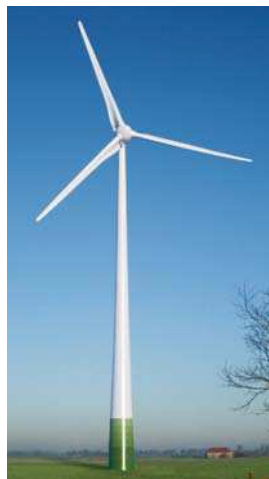
Vindturbin fra tyske Enercon, beregnet for innlandslokaliteter. Rotordiameter 82 m.
