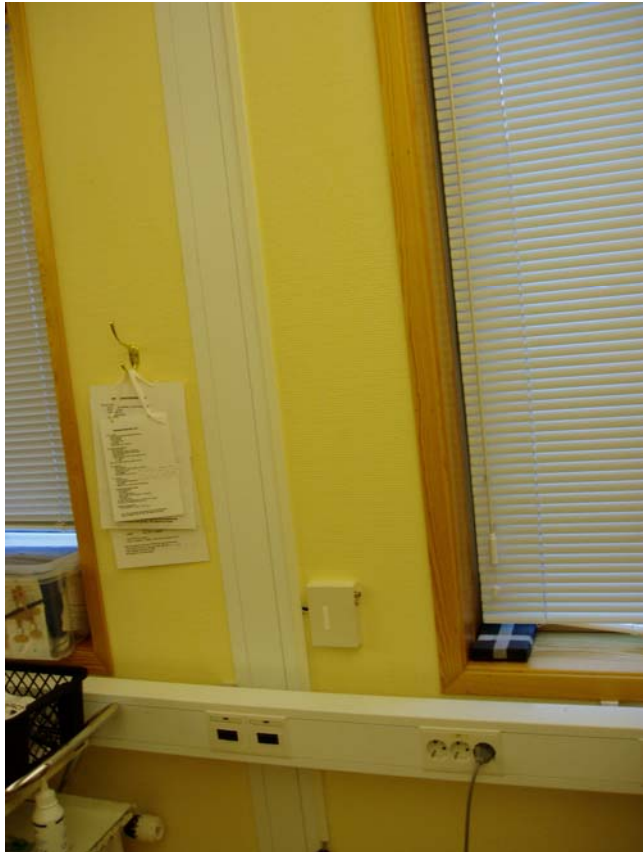
Bilde 1: Vegg på akuttrom - viser kanal for uttak av strøm og datanettverk
